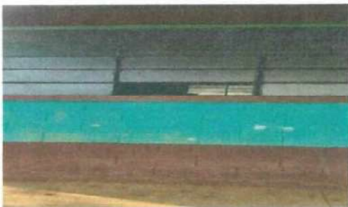
Foto 5: Se observa que la ventaneria de vidrio se encuentra en mal estado, presentando daños como cristales rotos, marcos deteriorados y sellados deficientes.
